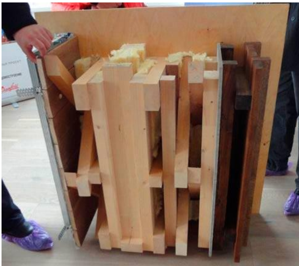
Рисунок 2. Разрез стены.
