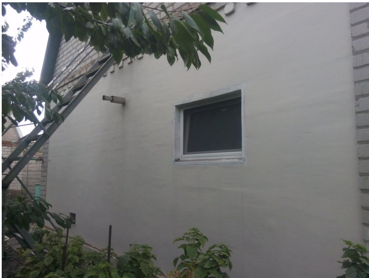
Рис. 1. Фасад здания после монтажа первого слоя утеплителя
