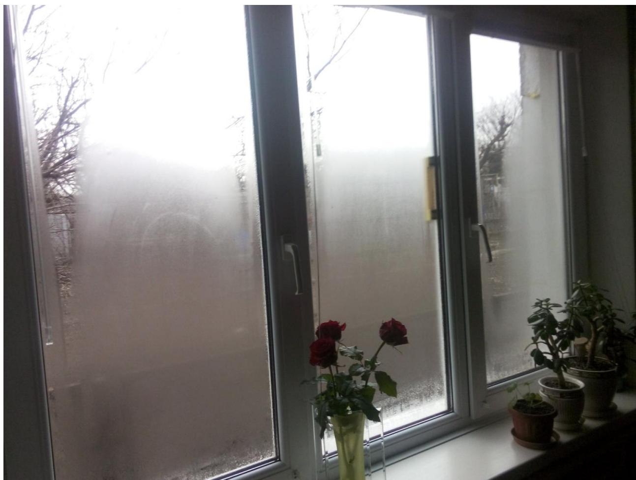
Рис. 3. Образование конденсата на стеклопакетах
