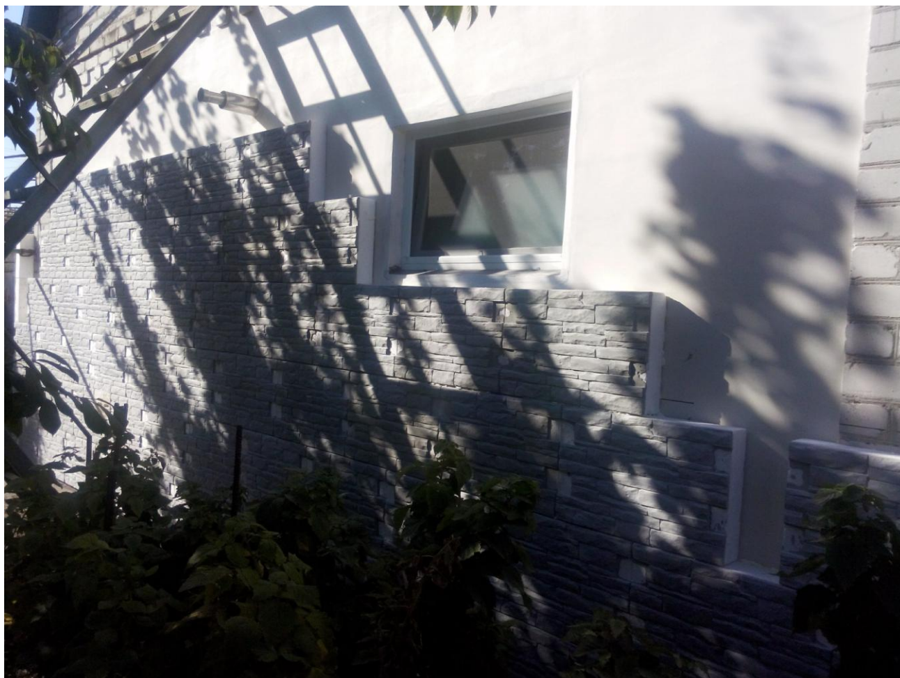
Рис. 2. Фасад здания в процессе монтажа второго слоя утеплителя
