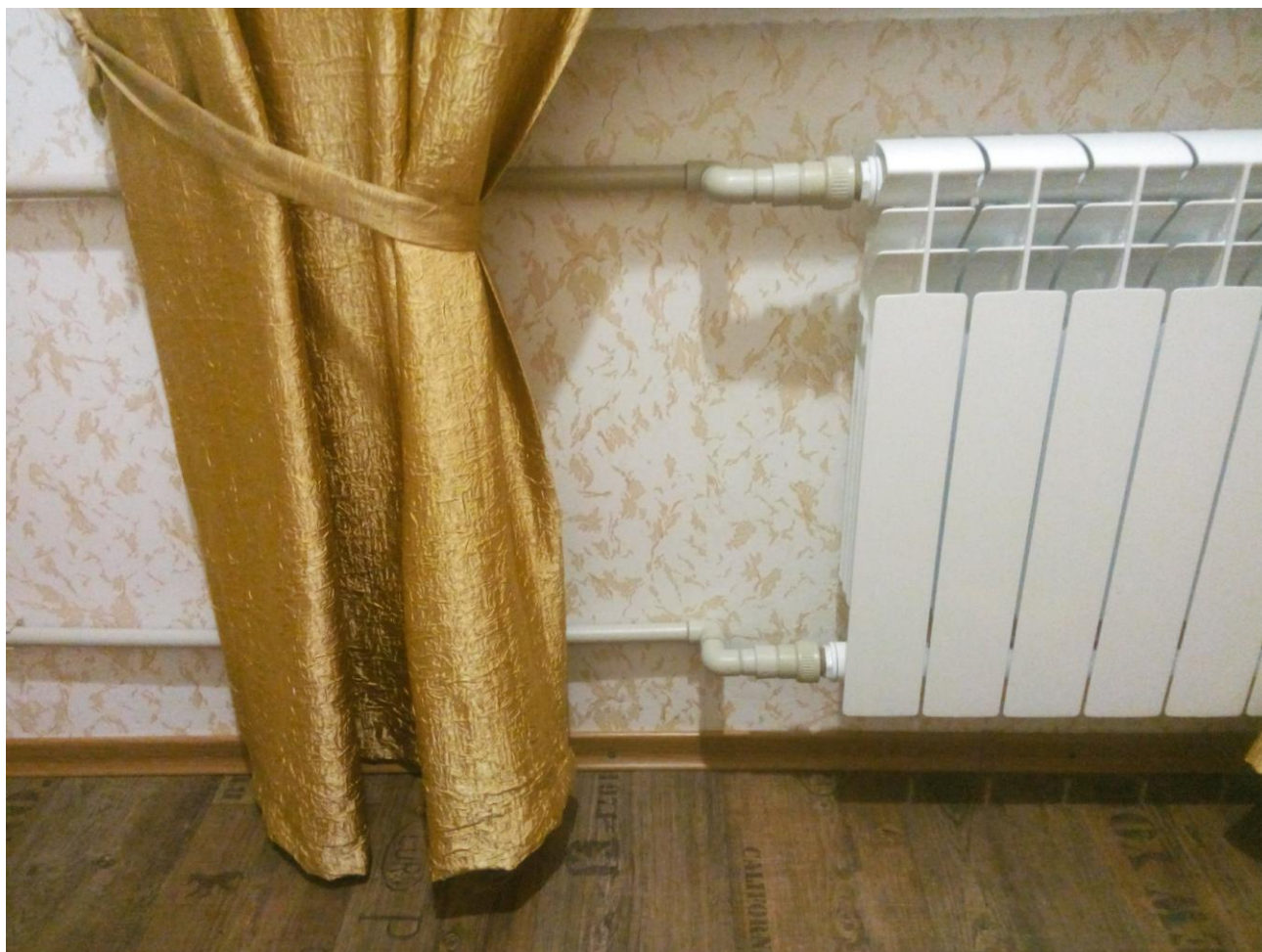
Рис. 8. Локализация очага грибкового поражения в местах с малой циркуляцией воздуха
