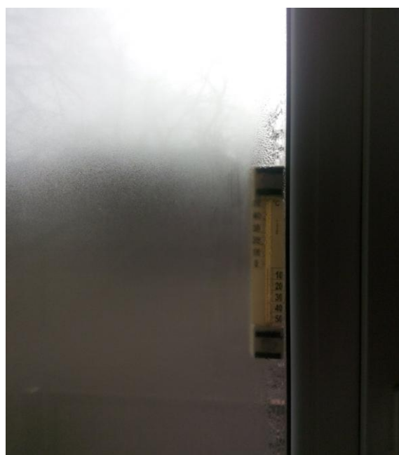
Рис. 4. Образование конденсата на стеклопакетах при температуре внешнего воздуха -1^{\circ}\text{C}
